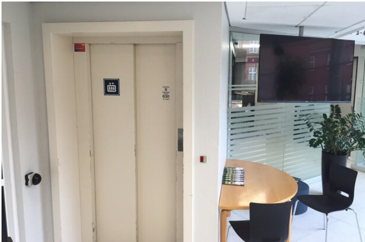
Rådhusets elevator i forhallen. Foto: Frederikssund Kommune.
