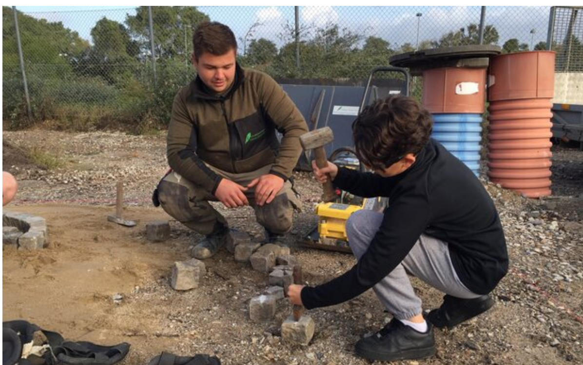
Der øves i at flække chausséstén. Foto: Frederikssund Kommune.
