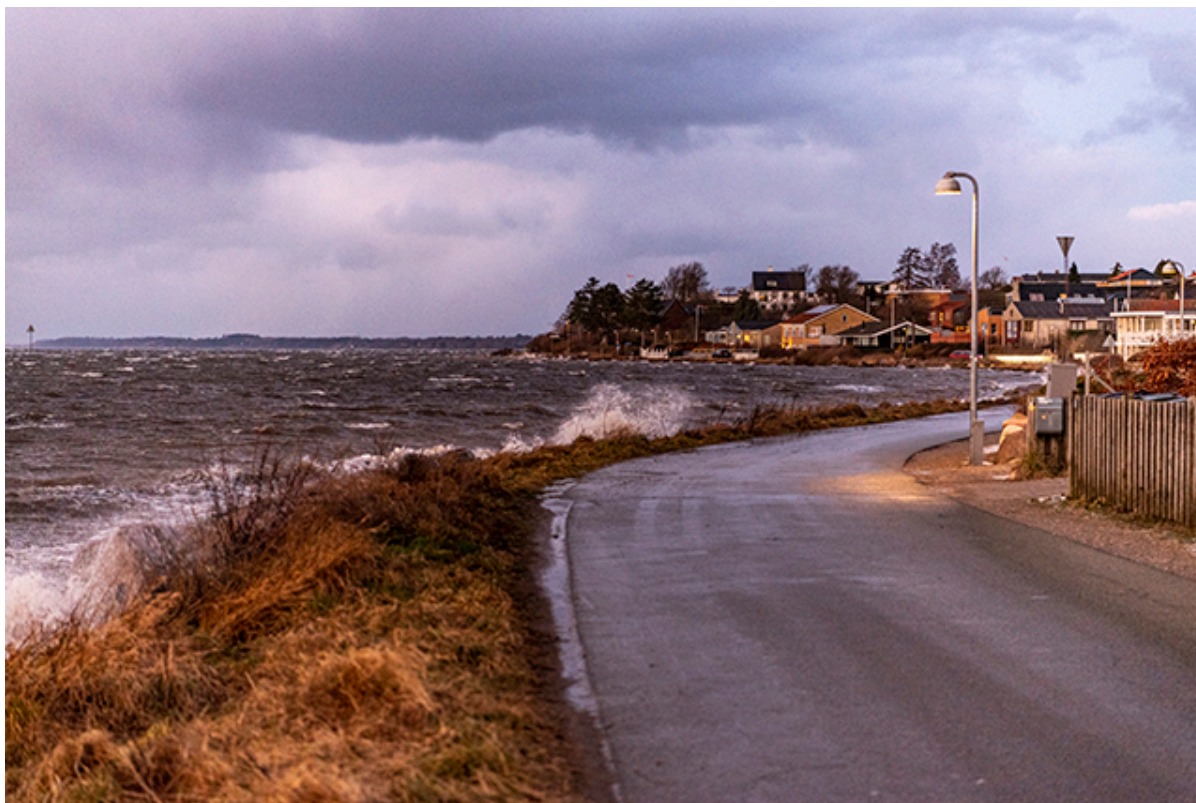
Strandvej med vandet piskende ind over. Foto: Frederikssund Kommune, Kenneth Jensen.
