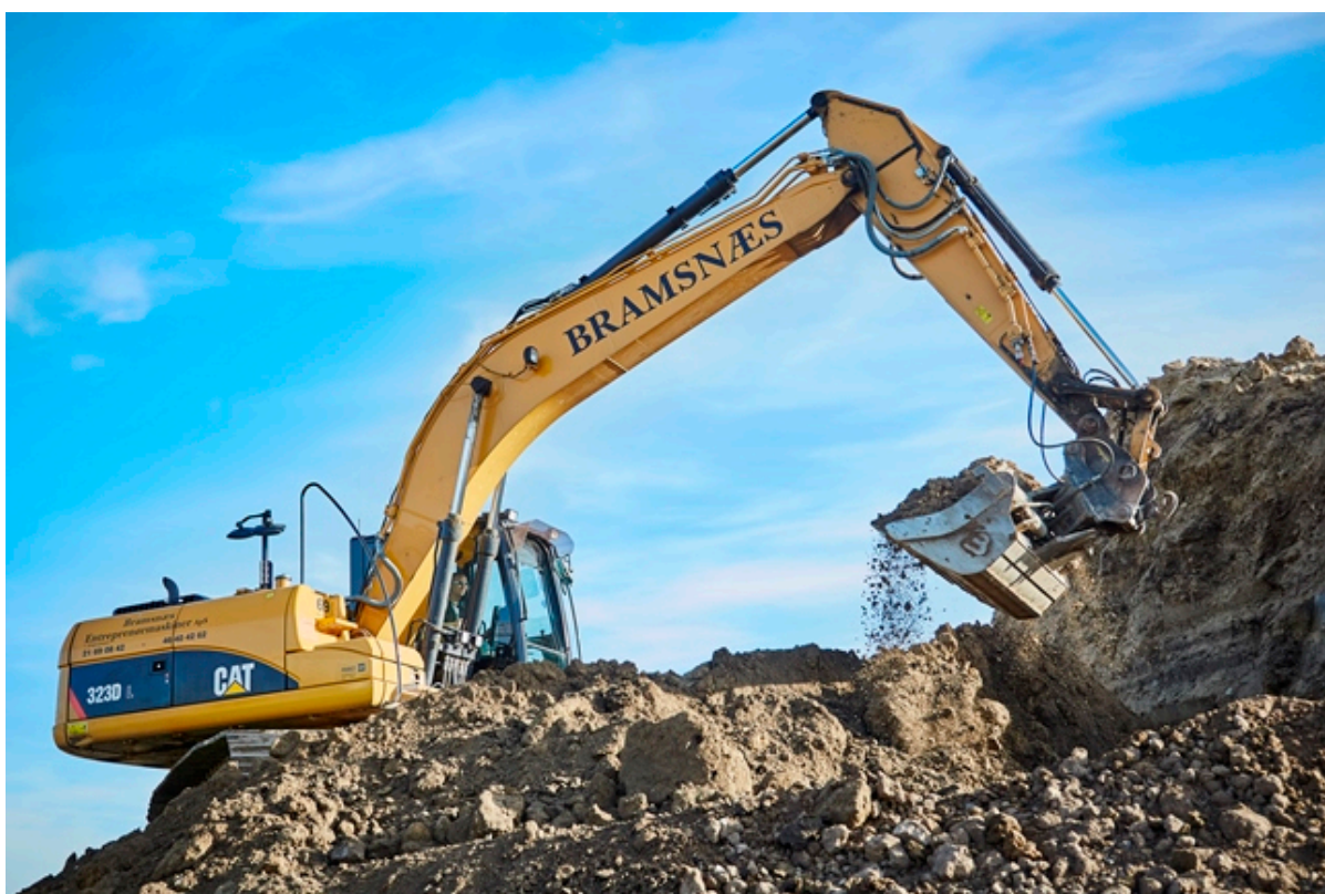
Gravemaskine graver i jorden. foto: Frederikssund Kommune.
