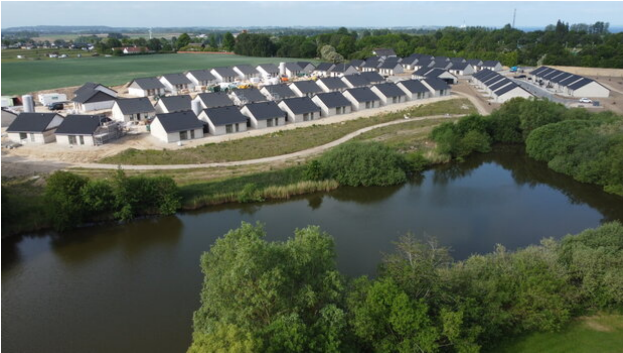
I Jægerspris på den nye vej Toftekær er der bygget over 60 nye boliger.
