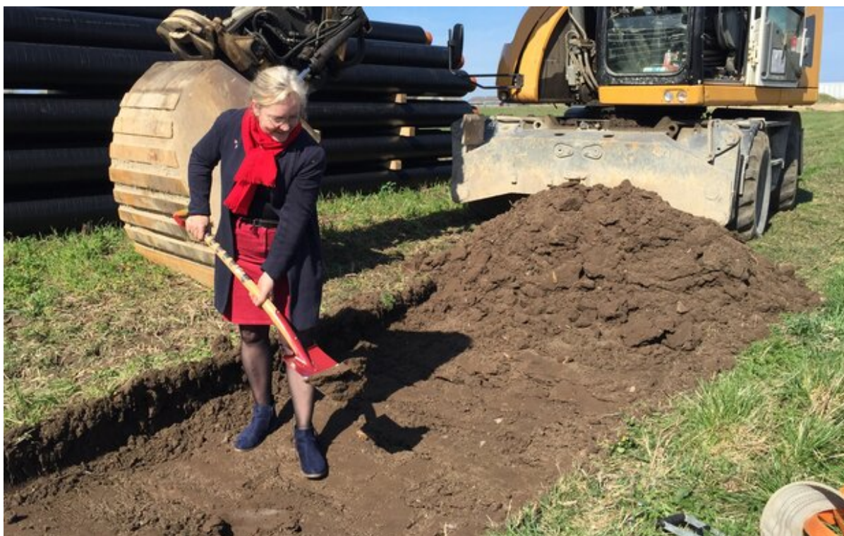
Borgmester Tina Tving Stauning (A) tager første spadestik. Foto: Frederikssund Kommune.
