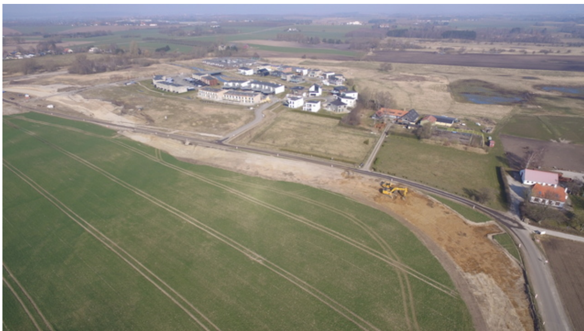
Vejarbejde på Dalvejen. Foto: Frederikssund Kommune.
