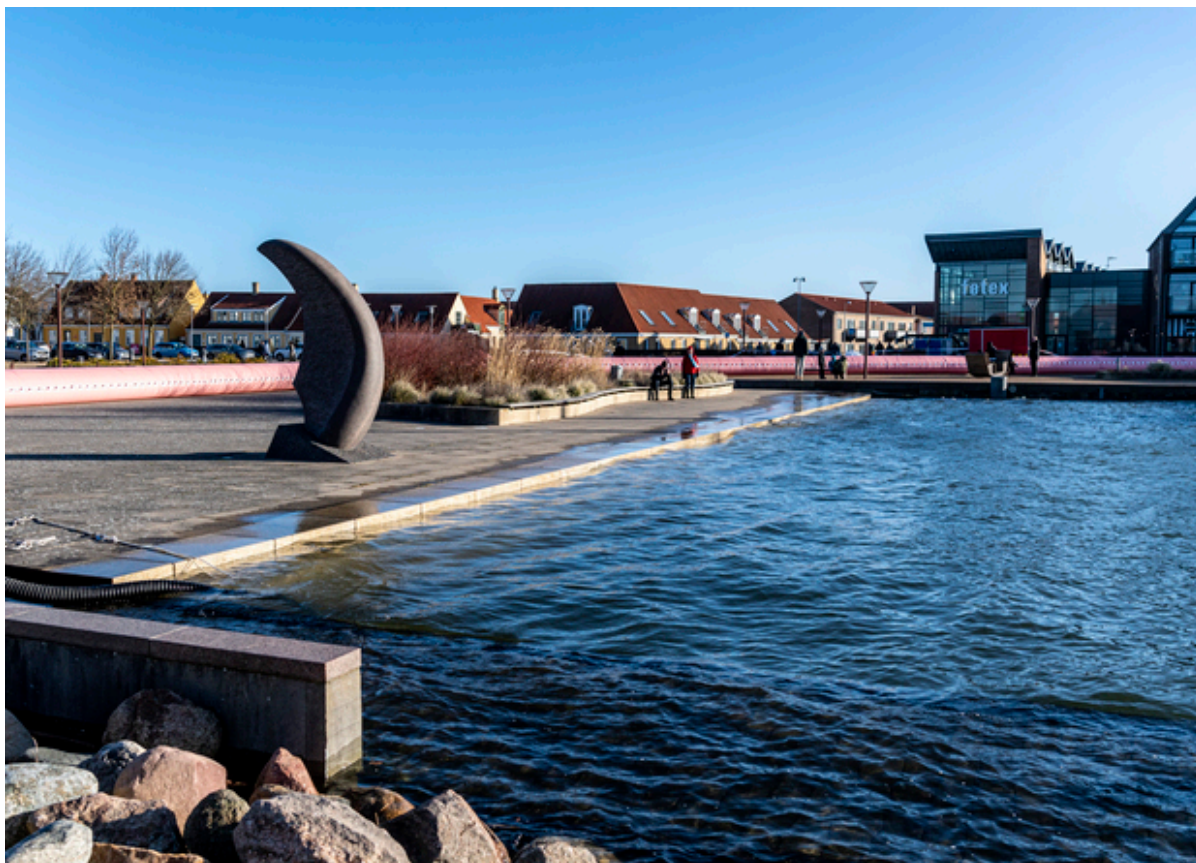
Frederikssund Havn under stormfloden Malik i januar 2022. Foto: Frederikssund Kommune, Kenneth Jensen.
