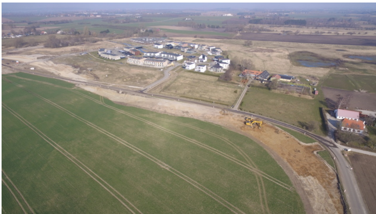
Vejarbejde på Dalvejen. Foto: Frederikssund Kommune.
