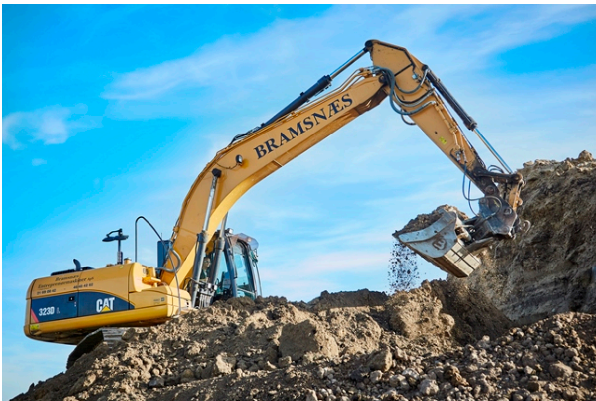
Gravemaskine graver i jorden. foto: Frederikssund Kommune.
