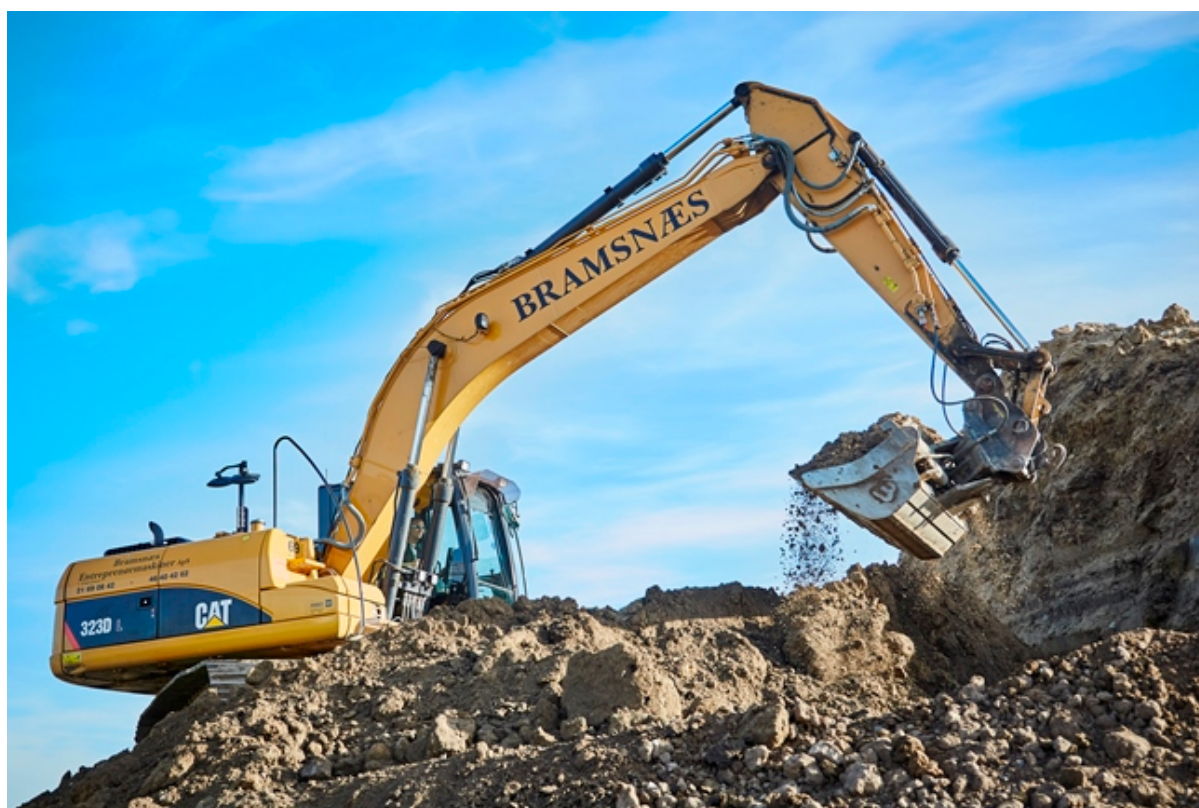
Gravemaskine graver i jorden. foto: Frederikssund Kommune.
